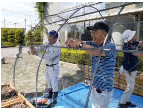
トンネルの骨組み解体 (8/29)
